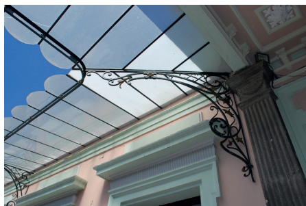
Ménsula de la marquesina del patio de la Casa “de La Palma”.
