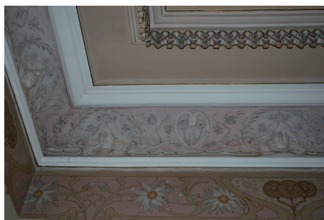
Detalle de la pared y del techo de la sala de música de la Casa Presno.
