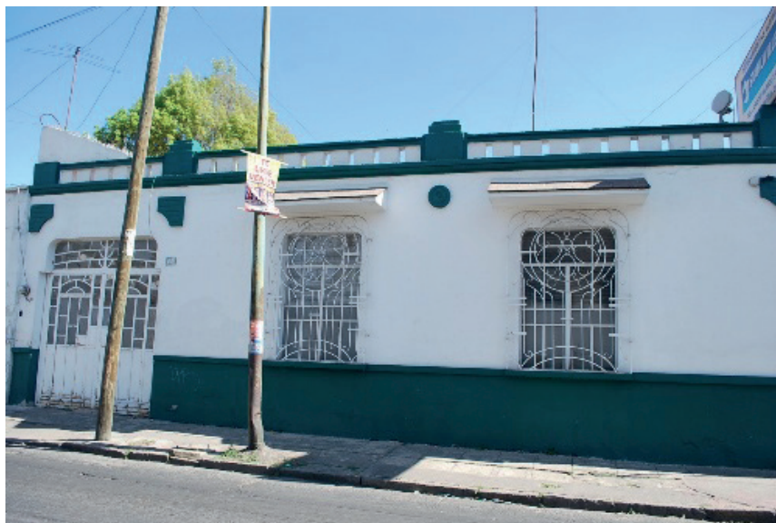
Vista general de la fachada de 5 Sur 1706.
