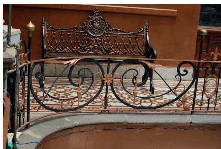
Detalle de la barandilla del patio del Conservatorio de Música del Estado de Puebla.
