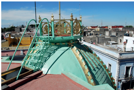
Detalle del coronamiento de la cúpula en el exterior del edificio en Avenida Reforma 725 esquina 9 Sur.
