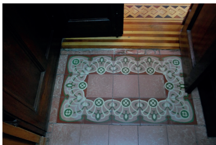
Pavimento hidráulico de la Casa Caso.
