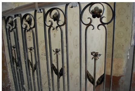
Barandilla de la escalera en Avenida Reforma 917 (Fotografía previa a la restauración).
