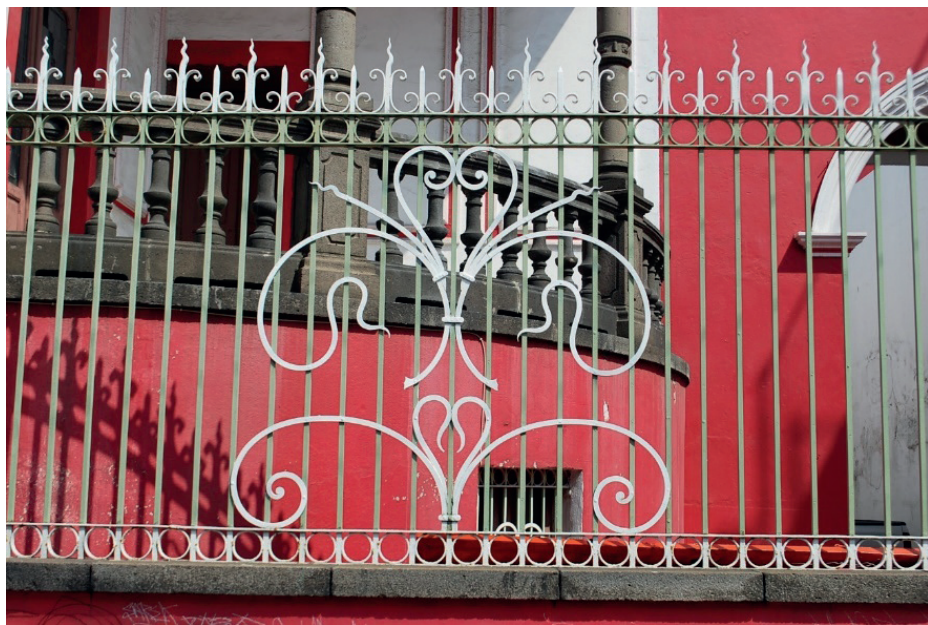
Reja en el muro de Avenida Reforma 1506.
