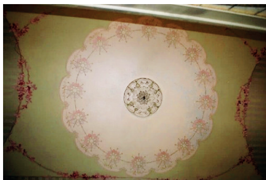
Arriba: Techo del baño en 2 Poniente 108.
