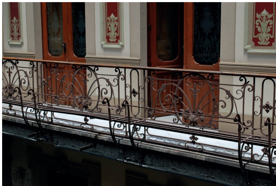
Barandilla del corredor del patio en la primera planta de la Casa Presno.
