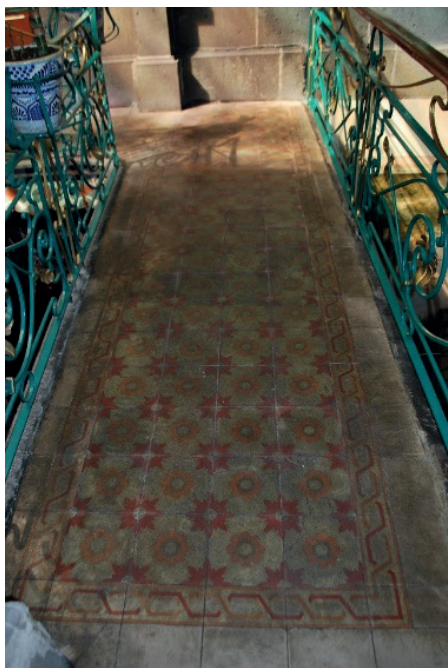
Pavimento hidráulico en el patio en Avenida Reforma 725 esquina 9 Sur.
