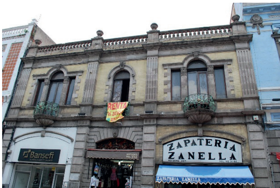
Fachada de la casa en Avenida Reforma 334.
