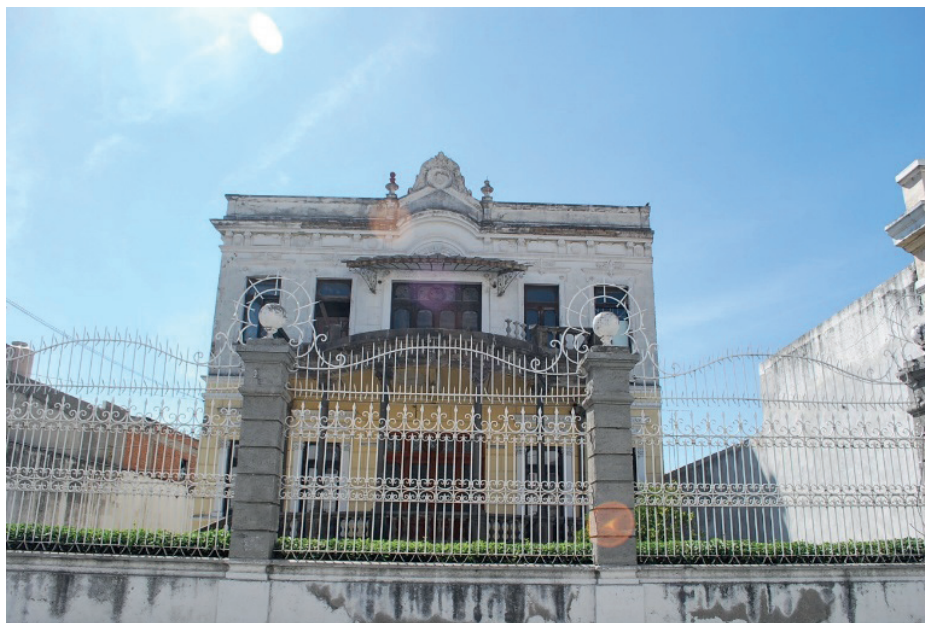
Vista general de la fachada de 9 Poniente 1507.
