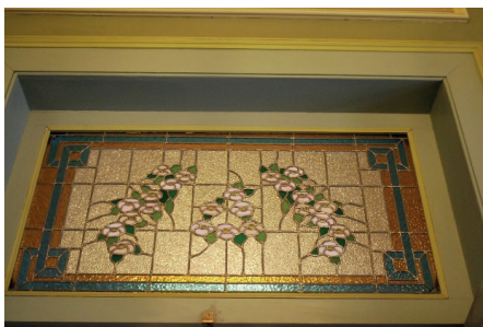
Dintel de la puerta del despacho de la casa en Avenida Reforma 515.
