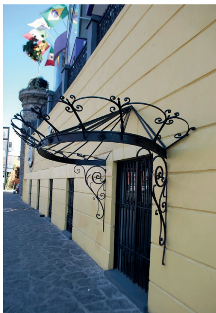
Cubierta con ménsulas de una puerta de Villa Flora.
