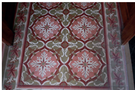
Modelo de pavimento hidráulico en un pasillo de 7 Sur 107.
