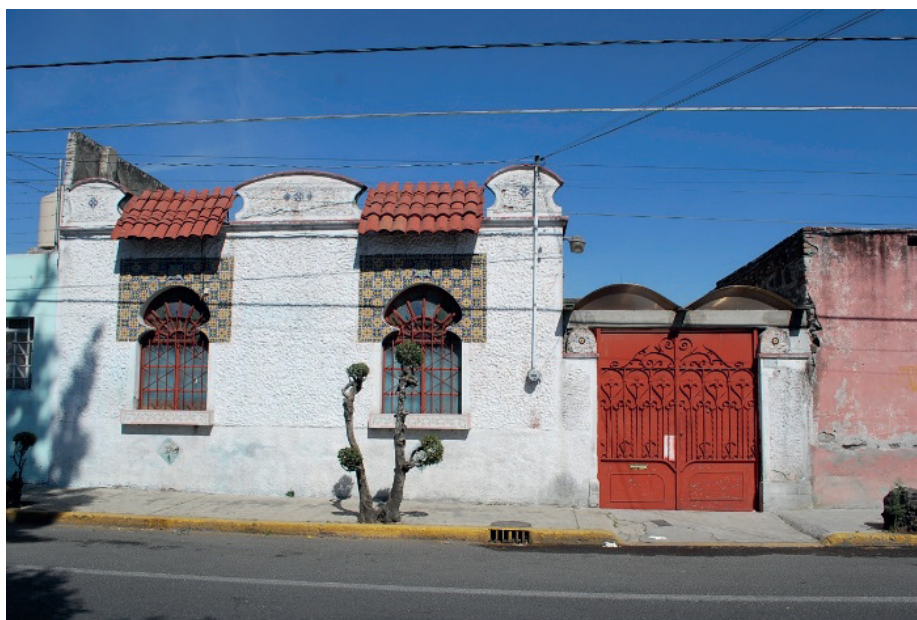
Vista general de la fachada de 21 Poniente 1720.
