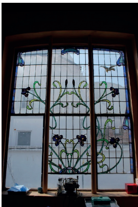
Ventanal en Avenida Reforma 1302.
