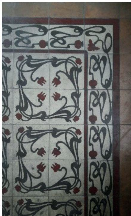
Pavimento hidráulico en 2 Poniente 323. Fotografía de Pedro Sardà.
