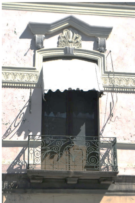
Detalle de un ventanal de 2 Poniente 516.
