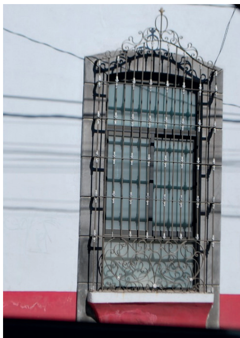
Ventanal en 13 Poniente 510.
