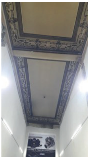
Fotografía del techo del zaguán en Avenida Reforma 104. Fotografía de Pedro Sardà.
