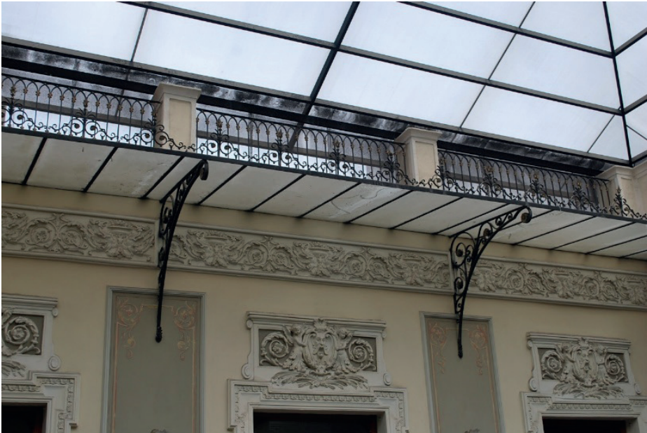
Ménsulas que sostienen la cubierta del patio en la Casa Matienzo o Edificio de la Lotería Nacional.
