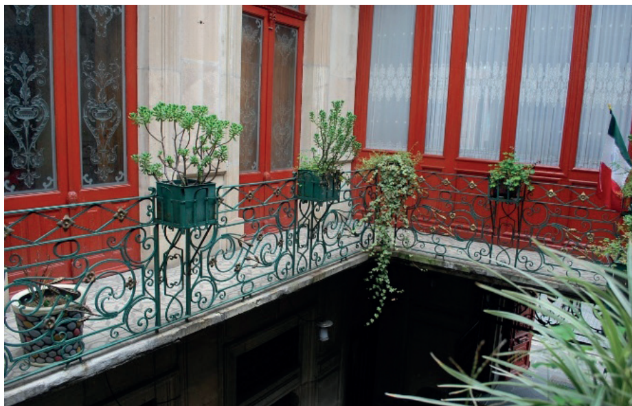
Barandilla del patio de la casa en Avenida Juan de Palafox y Mendoza 218.
