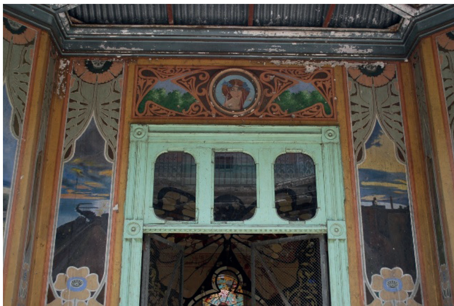
Detalle de la parte superior de las paredes del pabellón central de la Hacienda de Santa Águeda.
