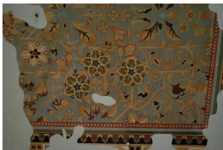
Detalle de la pintura mural del techo del comedor en 2 Norte 606.
