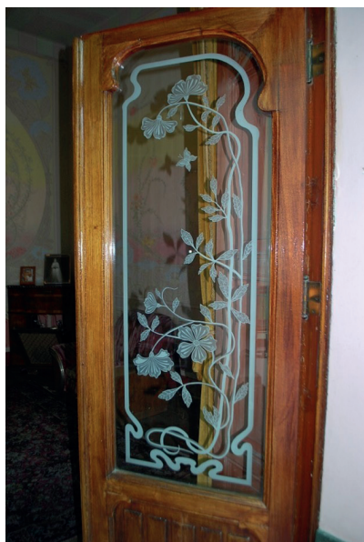
Vidrio grabado al ácido en la puerta de la primera habitación Art Nouveau de la Casa Rangel.
