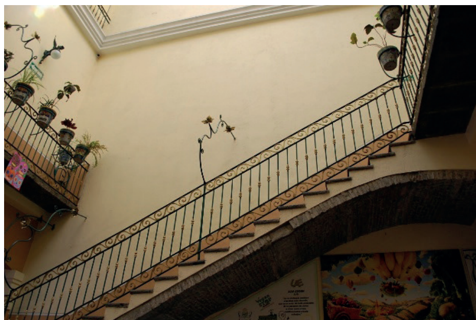
La aplicación en la barandilla de la escalera del patio principal en Avenida Reforma 723.
