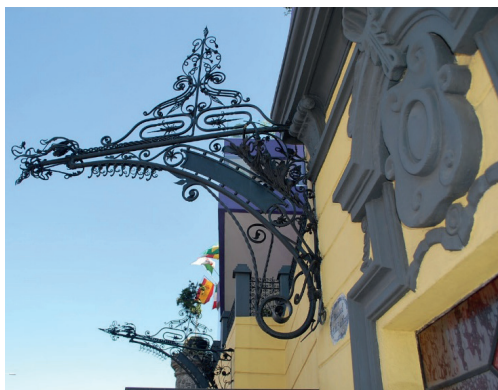
Aplicación en la fachada de Villa Flora.
