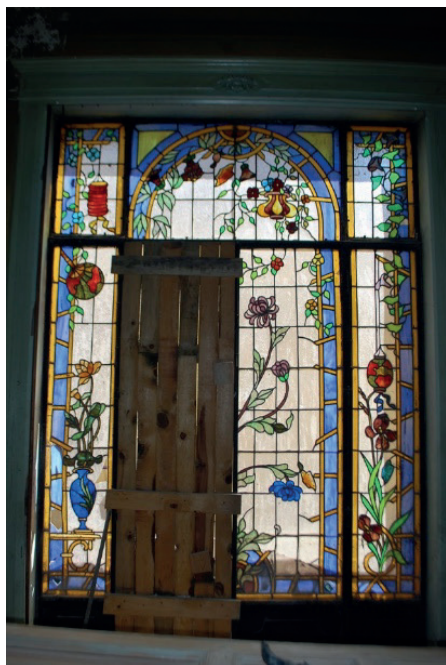
Ventanal en Avenida Reforma 917 (Fotografía previa a la restauración).
