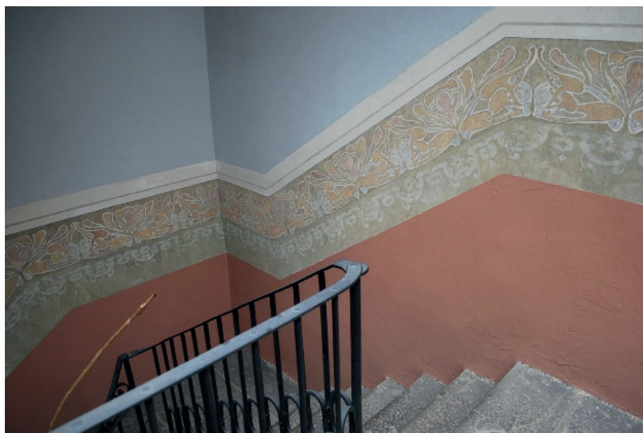
Vista general de las escaleras que conectan los diferentes niveles en 5 Poniente 309.
