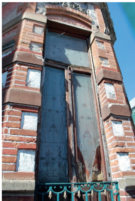
Un ventanal del torreón en 13 Sur 707.
