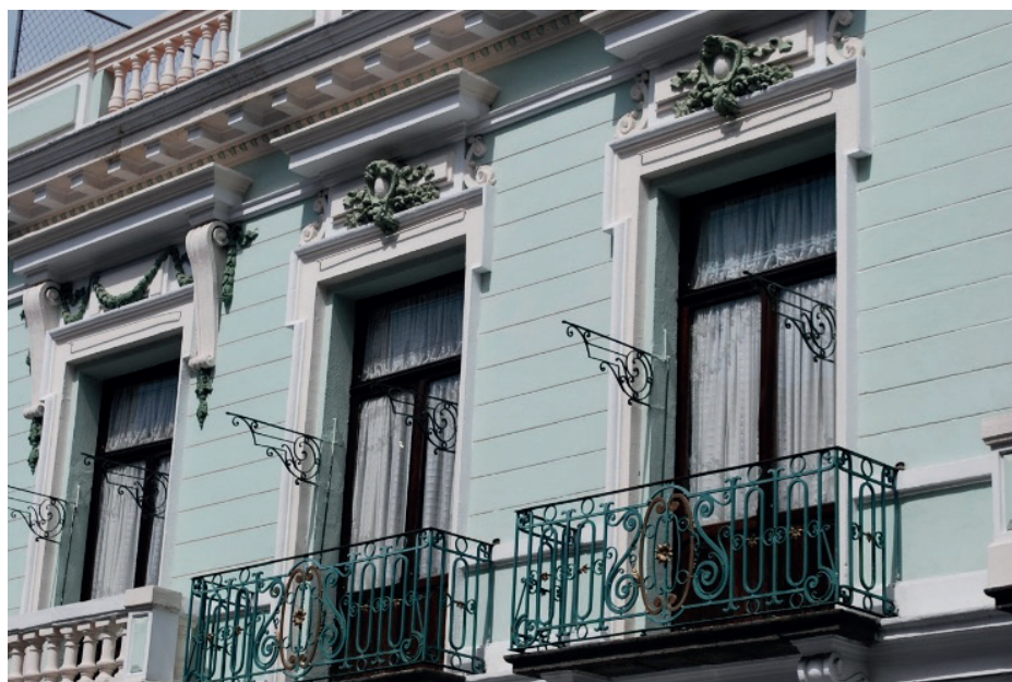
Detalle de algunos ventanales con balcones y ménsulas de la Casa “de La Palma”.
