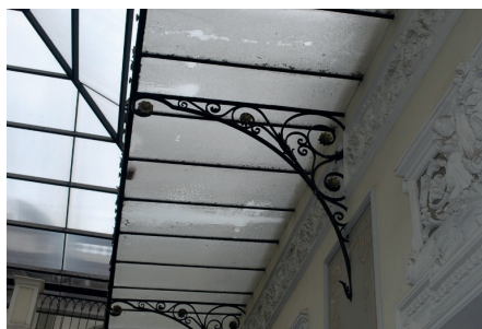
Detalle de una ménsula que sostiene la cubierta del patio en la Casa Matienzo o Edificio de la Lotería Nacional.
