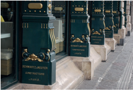
Arriba: Pilares en la fachada de La Ciudad de México o Fábricas de Francia.
