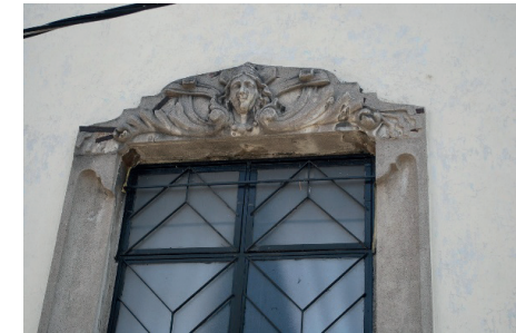
Dintel de una ventana de 3 Sur 1708.
