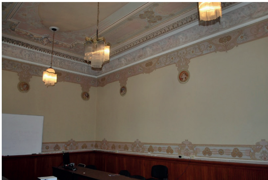
Vista general de la sala de música de la Casa Presno.
