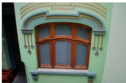
Ventanal del primer nivel en el patio de 7 Sur 107.
