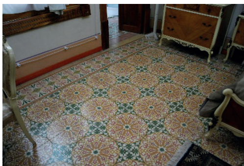
Pavimento hidráulico en una habitación de 7 Sur 107.
