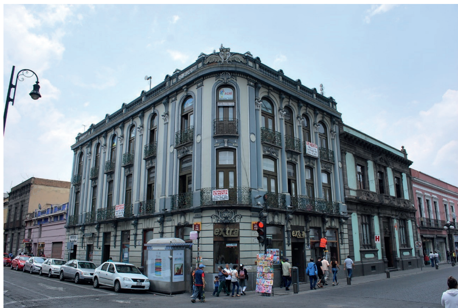
Vista general de la fachada del Edificio Margarita.
