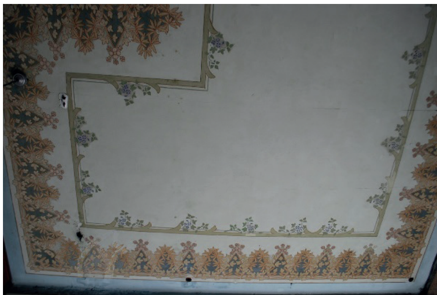
Pintura mural en el techo del patio de la Casa Cué.
