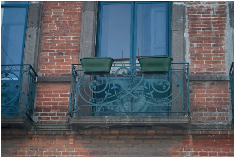
Detalle de un balcón en Avenida Reforma 1519.
