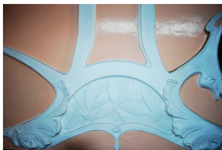
Detalle de una pared del baño en 2 Poniente 108.
