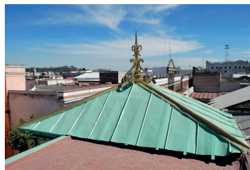
Detalle del pináculo en el coronamiento del edificio en Avenida Reforma 725 esquina 9 Sur.
