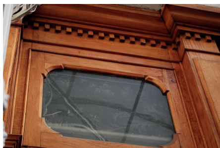
Detalle del dintel de la puerta de cerramiento en 3 Poniente 725 esquina 9 Sur.
