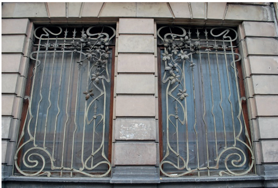
Rejas en la planta baja de la Casa Reynaud.
