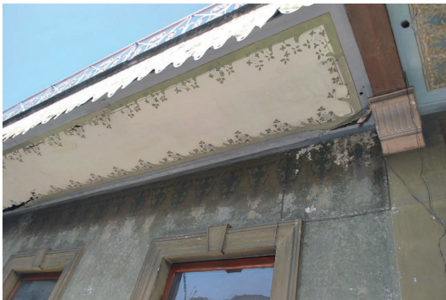
Pintura mural en la pared y el techo del patio de la Casa Cué.
