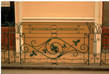
Barandilla del patio en 2 Norte 606.
