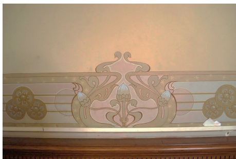
Detalle de la franja inferior de la pared de la sala de música de la Casa Presno.
