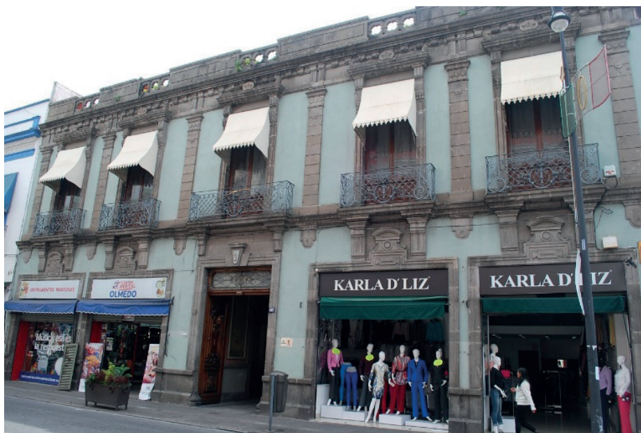
Vista general de la fachada de la Casa Caso.
