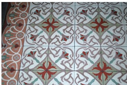
Pavimento hidráulico en una de las estancias en 13 Sur 2102 esquina 21 Poniente 1113.
