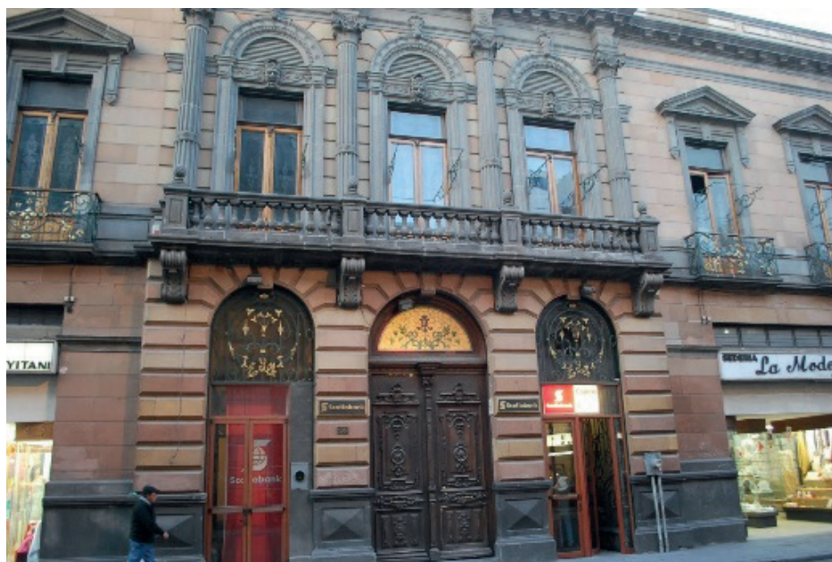
Vista general de la fachada de 2 Poniente 106.
