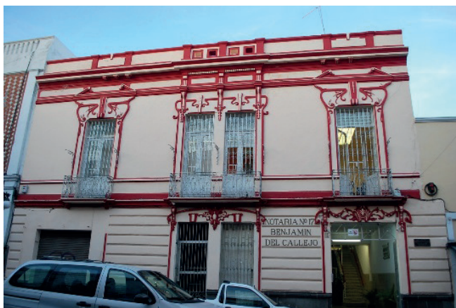
Vista general de la fachada de 5 Poniente 116.
