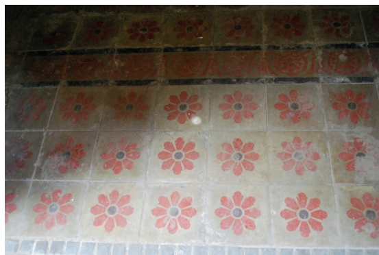
Pavimento hidráulico del lavabo para el aseo de los operarios y vaqueros de la Hacienda de Santa Águeda.
