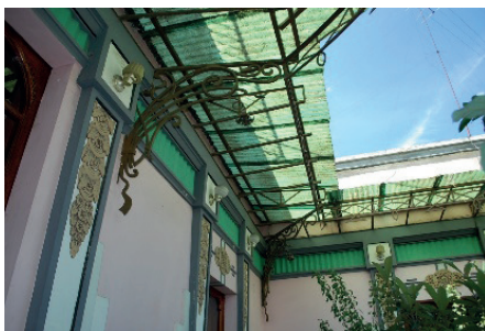
Ménsulas de la marquesina del patio central de la Casa Rangel.
