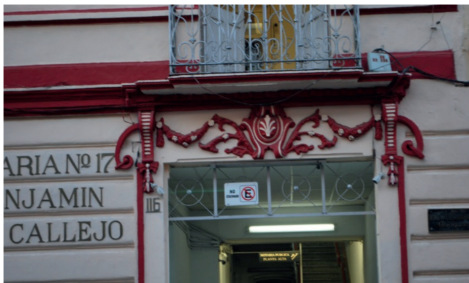
Detalle de las molduras de la puerta principal en 5 Poniente 116.
