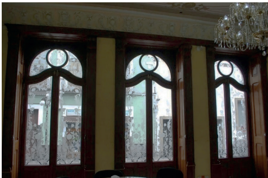
Conjunto de ventanas desde el interior de la Casa de la Reina.
