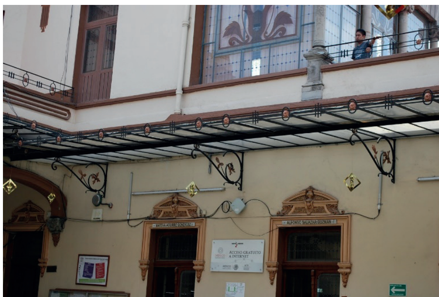
Ménsulas de la marquesina del patio del Conservatorio de Música del Estado de Puebla.
