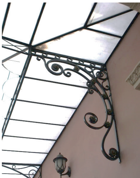
Ménsula de la marquesina del patio principal de la Casa de la Reina.
