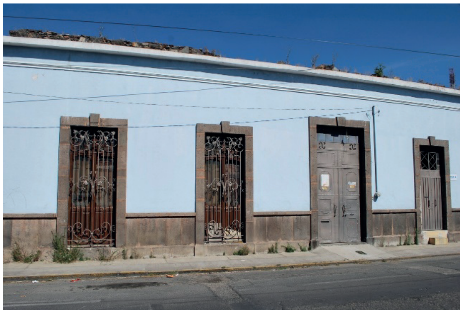
Vista general de la fachada de 17 Poniente 1506 A.
