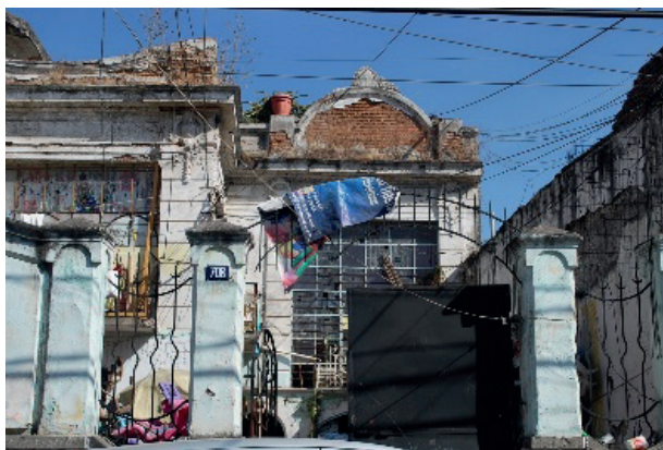
Vista general de la fachada de 20 Poniente 708.
