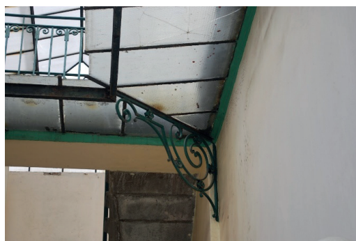
Arriba: Ménsula en el patio de la casa en Avenida Juan de Palafox y Mendoza 218.
