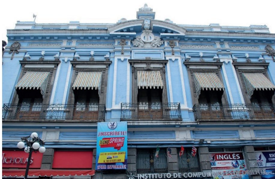
Fachada de la casa en Avenida Reforma 330.
