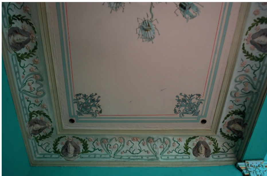
Techo del zaguán en Avenida Reforma 907.
