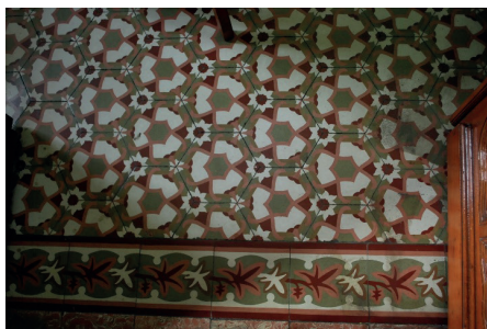
Modelo de pavimento hidráulico en 7 Sur 107.
