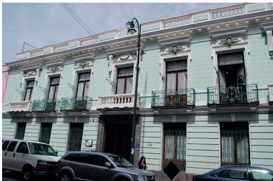
Vista general de la fachada de la Casa “de La Palma”.
