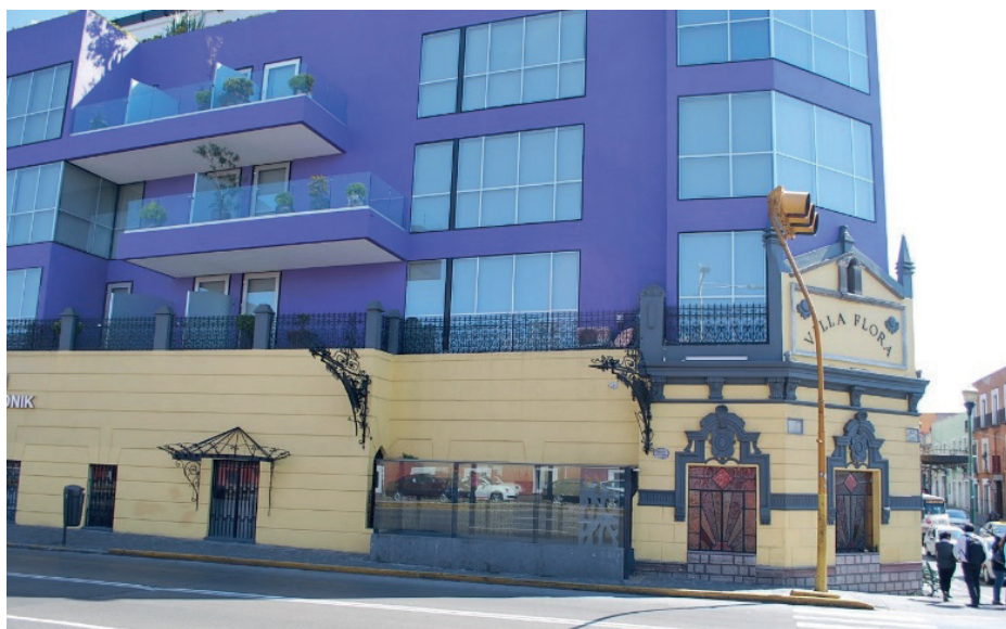
Vista general de un lado de la fachada de Villa Flora.
