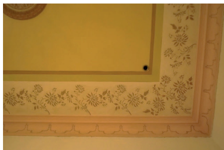
Pintura mural de una habitación de la casa en Avenida Reforma 515.
