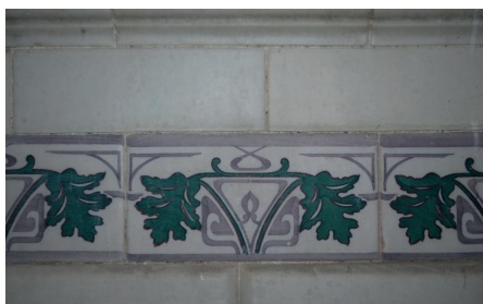
Cerámica en los baños de Avenida Reforma 917 (Fotografía previa a la restauración).
