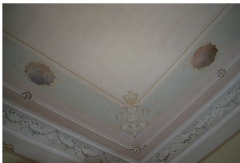
Techo de la primera habitación Art Nouveau de la Casa Presno.
