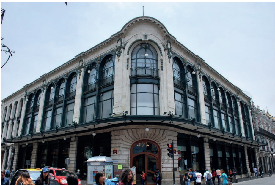
Vista general de la fachada de La Ciudad de México o Fábricas de Francia.
