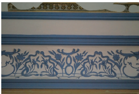
Detalle de la escayola del techo del comedor en 2 Norte 606.
