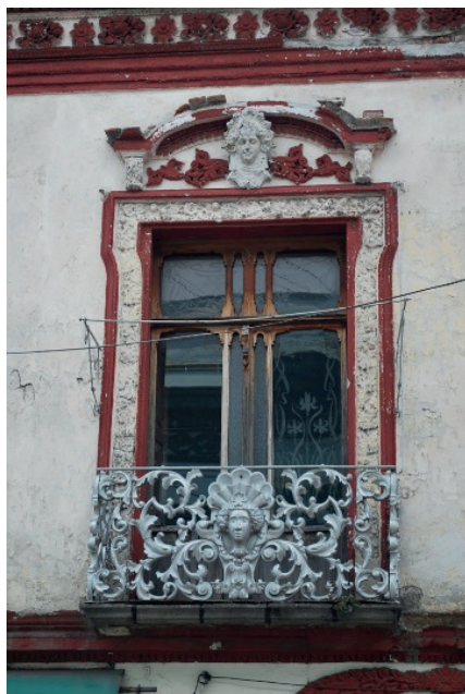
Balcón central del primer nivel en 3 Poniente 709.
