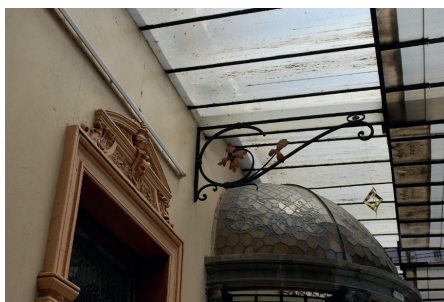
Ménsula de la marquesina del patio del Conservatorio de Música del Estado de Puebla.
