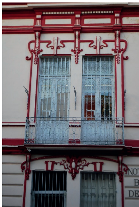
Detalle de las molduras de los ventanales de la planta baja y del balcón del primer nivel en 5 Poniente 116.
