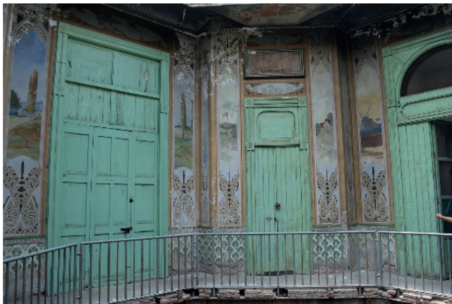
Vista general del hall en el Departamento de habitaciones para empleados de la Hacienda de Santa Águeda.
