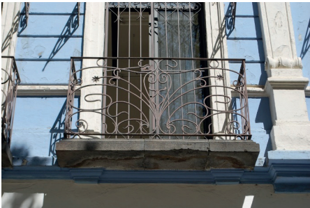
Detalle del balcón en Avenida Juárez 1316.
