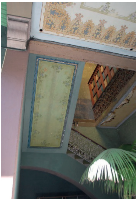
Vista general del hueco de la escalera del patio de la Casa Cué.
