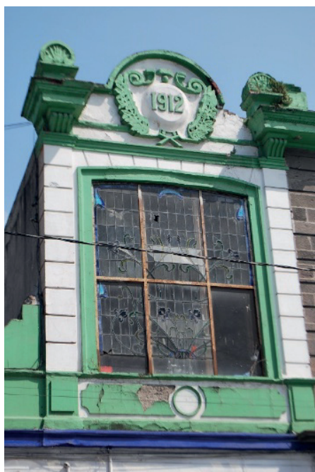
Anexo con ventanal en Avenida Reforma 1302.
