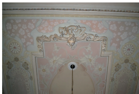
Detalle del techo de la sala de música de la Casa Presno.
