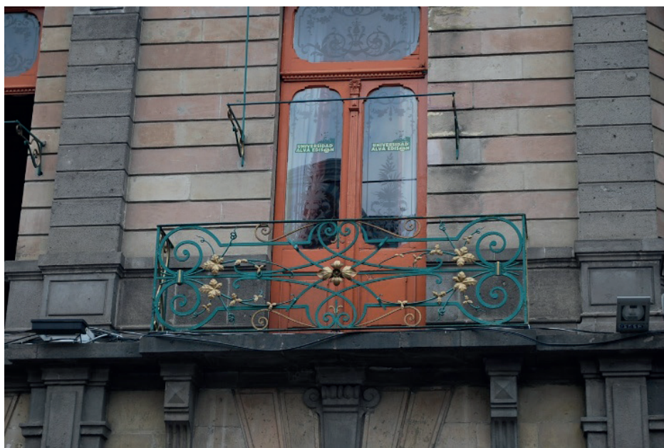
Balcón en la fachada del edificio en Avenida Reforma 725 esquina 9 Sur.
