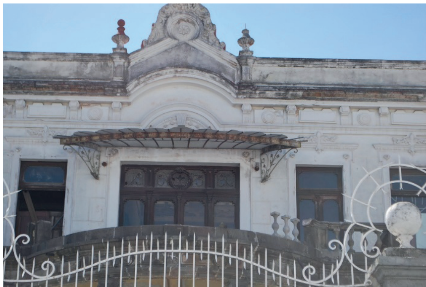
Detalle de la puerta principal con las ménsulas y la marquesina de 9 Poniente 1507.
