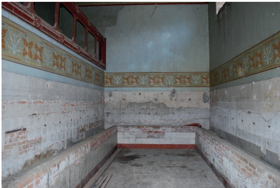
Vista general del lavabo para el aseo de los operarios y vaqueros de la Hacienda de Santa Águeda.
