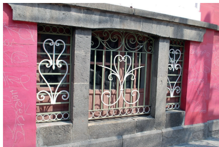
Rejas que comunican con el sótano en Avenida Reforma 1506.
