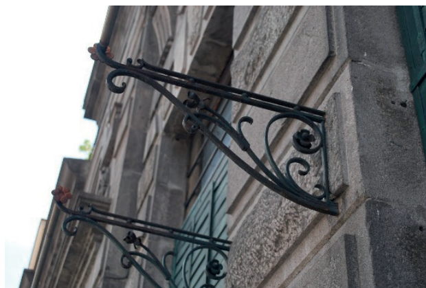
Detalles de las ménsulas de la fachada de 5 Poniente 519.
