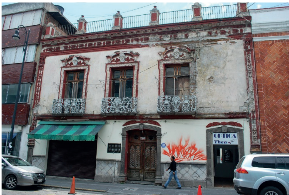
Vista general de la fachada en 3 Poniente 709.
