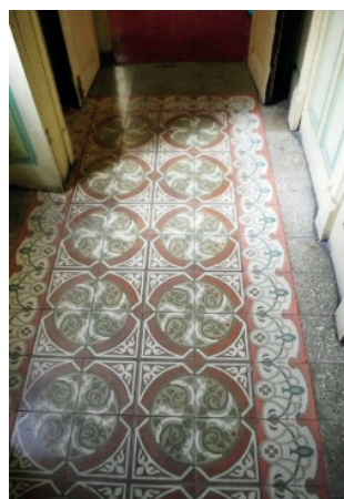
Derecha: Pavimento hidráulico en el suelo de 2 Poniente 108.
