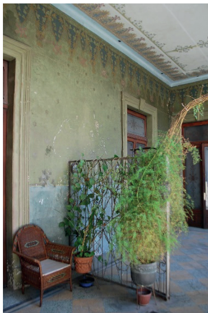
Vista general de una parte del patio de la Casa Cué.
