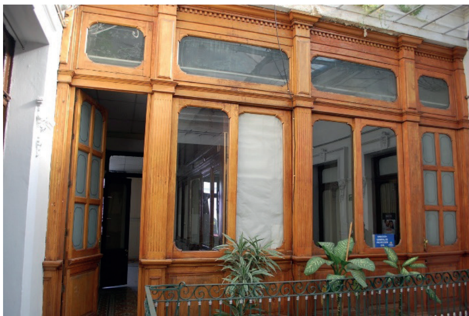
Puerta de cerramiento de la sala de estar en 3 Poniente 725 esquina 9 Sur.
