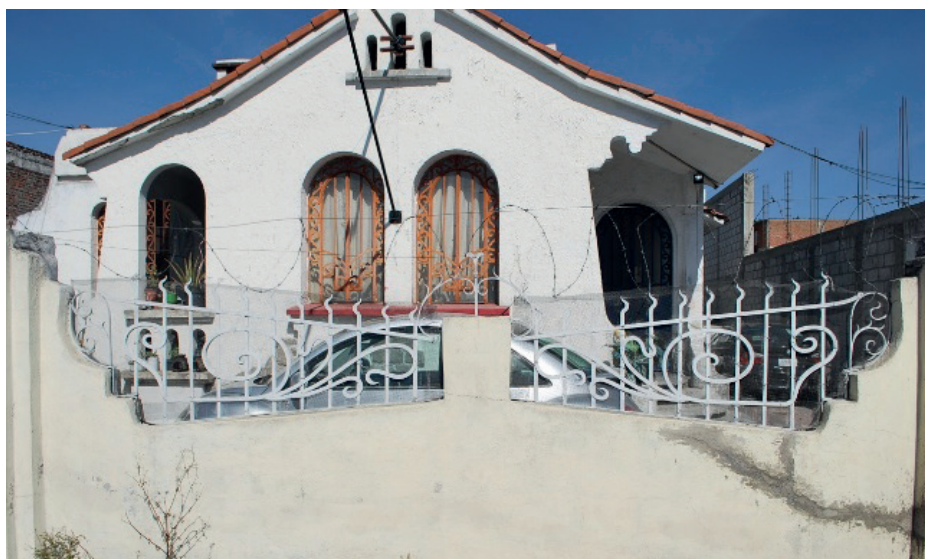
Detalle de las rejas del muro en 14 Oriente 2824.
