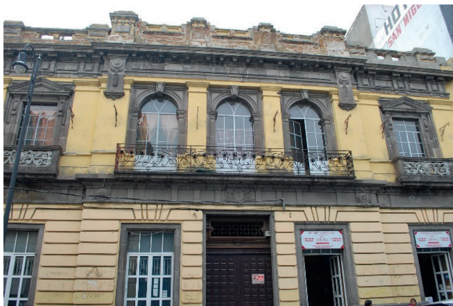
Vista general de la fachada en 3 Poniente 719.
