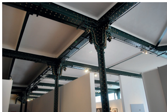
Arriba: Pilares en el interior de la Antigua Fábrica de Francia.
