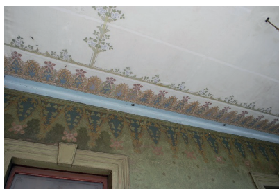
Detalle de pintura mural en la pared y el techo del patio de la Casa Cué.
