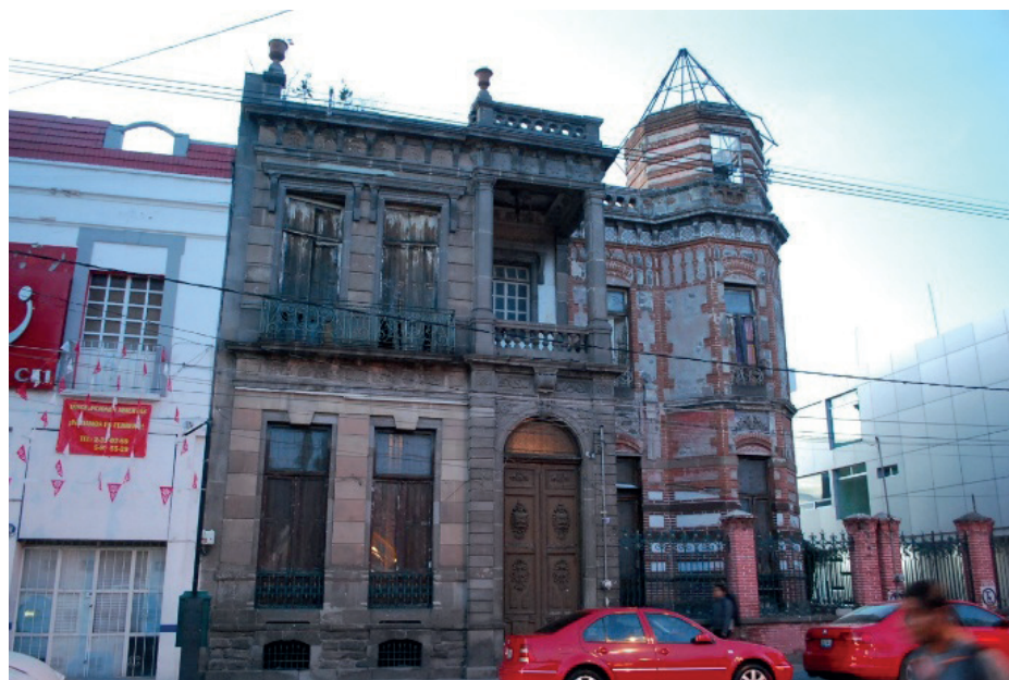
Vista general del exterior de 13 Sur 707.
