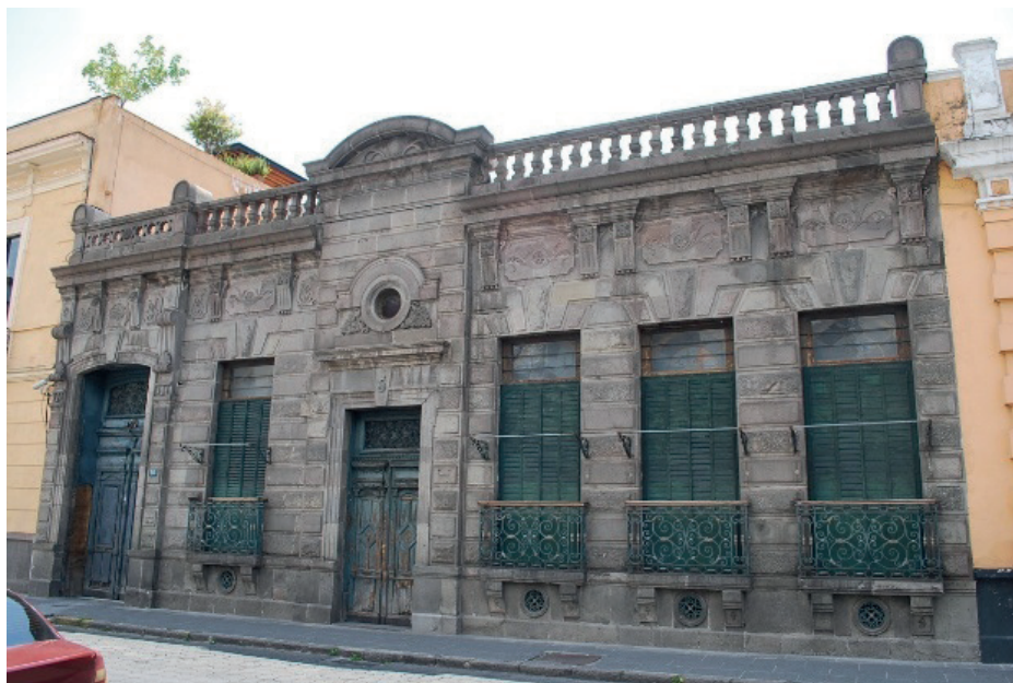
Vista general de la fachada de 5 Poniente 519.
