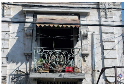
Barandilla del balcón de 20 Poniente 708.
