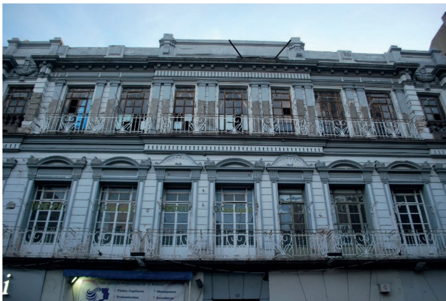
Fachada de la casa en Avenida Reforma 125.
