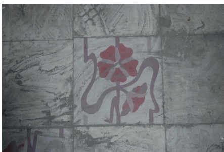
Detalle del pavimento hidráulico en el interior de la Casa de los Enanos.
