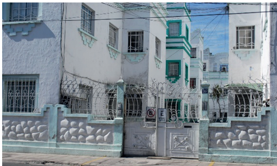
Puerta y rejas del muro de 7 Sur 1507.
