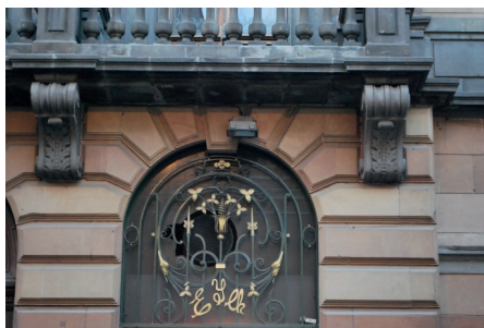
Arriba: Dintel de una de las puertas laterales en 2 Poniente 106.
