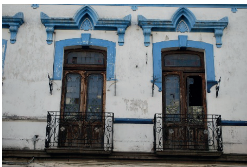
Arriba: Balcones de dos ventanales de 2 Poniente 317.
