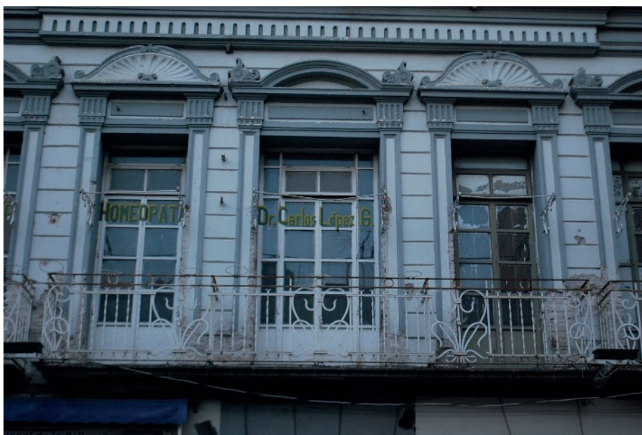
Detalle de la barandilla de uno de los balcones de la casa en Avenida Reforma 125.
