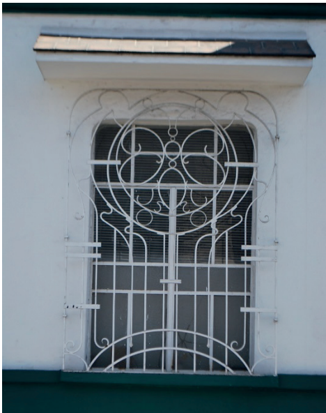
Ventana en la fachada de 5 Sur 1706.
